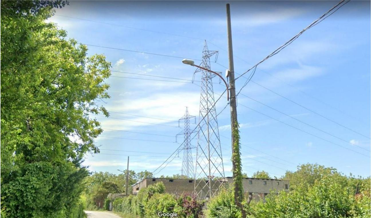
Tralicci della linea ad alta tensione (2) e linea elettrica a bassa tensione su pali C.A.C. (cemento armato centrifugato), come quelli che portavano la corrente alla ex IADA, sulla via Necropoli nei pressi del centro abitato di Pascarola.
