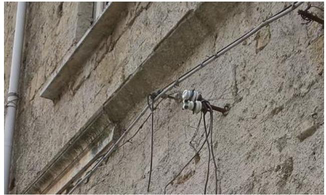
Staffe a muro a due conduttori con isolatori in ceramica bianca che sostenevano i cavi elettrici di rame all'ingresso dell'utenza dei bassi che si trovano in piazza C. Battisti.
