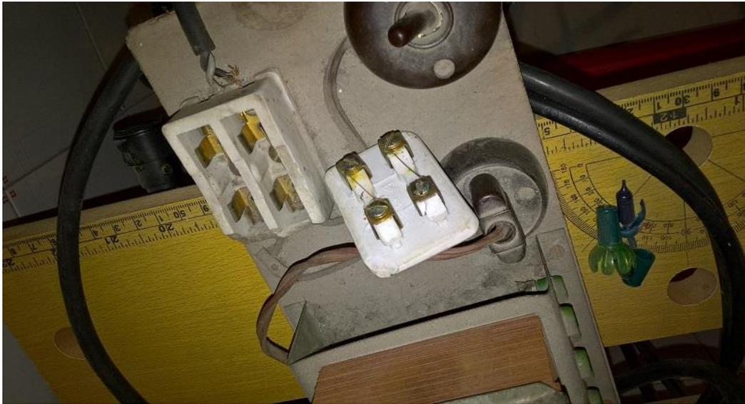
Interruttore, presa e fusibile a tabacchiera. Il fusibile era anche abbinato a vecchi contatori che quando sovraccarichi facevano bruciare il filo del fusibile che bisognava sostituire (foto fornita dall'ing. Salvatore Di Sarno).
