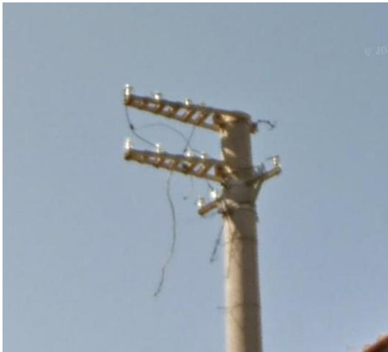
Il palo è armato in cima con mensole di cemento armato vibrato con isolatori di vetro su perni di ferro zincato. L'armatura aveva le stesse caratteristiche di quelle utilizzate per portare la corrente all'industria IADA.
