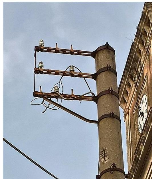
Sostegno della linea elettrica in via Matteotti nei pressi della Torre dell'Orologio costituito da palo in cemento armato, portante 3 staffe per 3 circuiti trifase per alimentare le case delle strade limitrofe.
