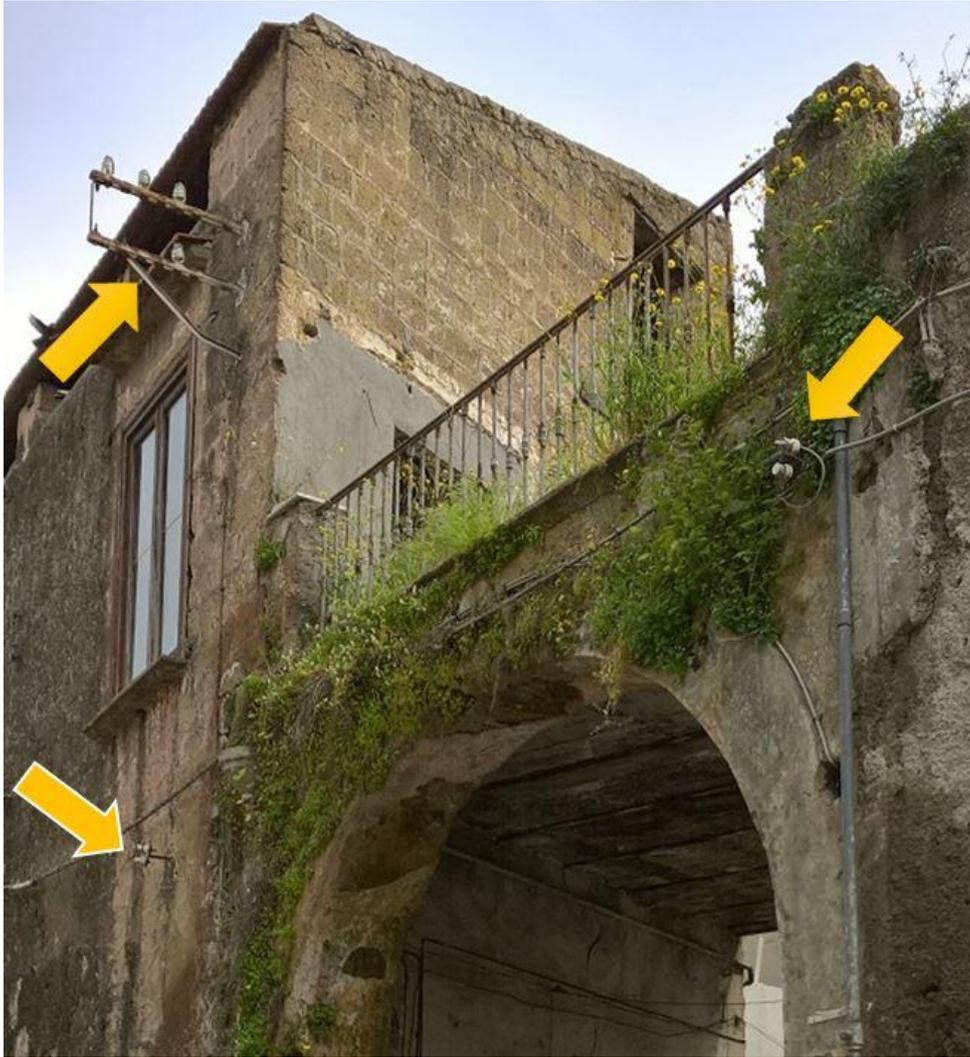
Via Mercadante – Sopra al fabbricato le due staffe in ferro infisse nel muro portanti due circuiti trifase e sotto la linea elettrica a due isolatori per singole utenze domestiche.
