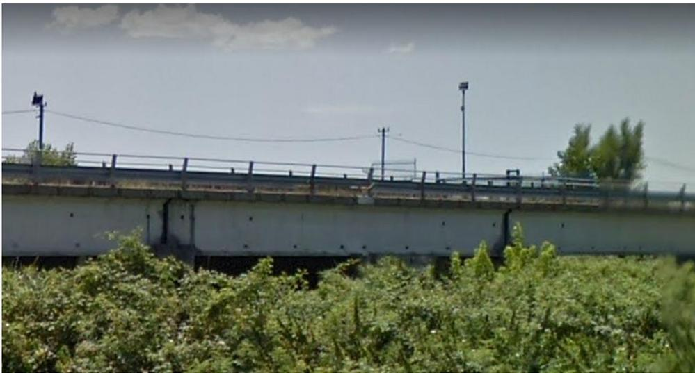
Da questa foto è evidente che il ponte sia stato rifatto in tempi recenti (anni '80-'90) risultando realizzato con grosse travi prefabbricate di cemento.
